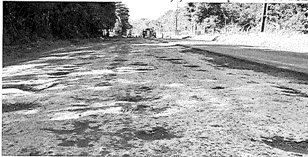
Foto 3: Base finalizada no km 10,9, com lançamento de TSD
