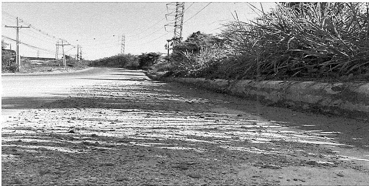
Figura 02: Retenção de material sólido a montante da boca de lobo, no sentido de Manaus pra Itacoatiara.
