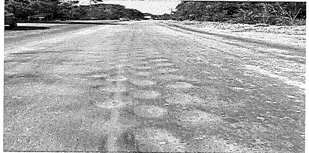
Foto 4: Base pronta imprimada no km 13,4
